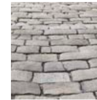
Ziegel im Halb- verband verlegt
