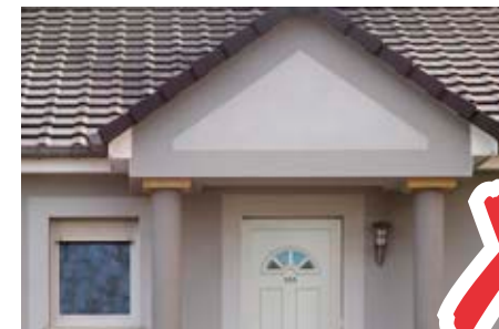
Unförmig große und unpassende Eingangsüberdachung
