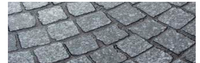
Verguss der Fugen mit Asphalt oder Mörtel.
