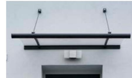
Leichte Konstruktion, z. B. Stahl - Glas
