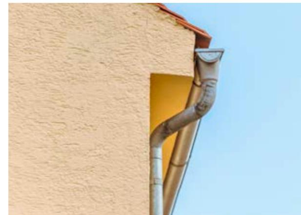
Die Ableitung des Regenwassers ist wichtig für die Entwässerung des Daches und zum Schutz darunterliegender Bauteile sowie der Passanten. Die Ausführung soll mit langlebigen, wiederverwertbaren Materialien wie Kupfer- oder Zinkblech erfolgen.
