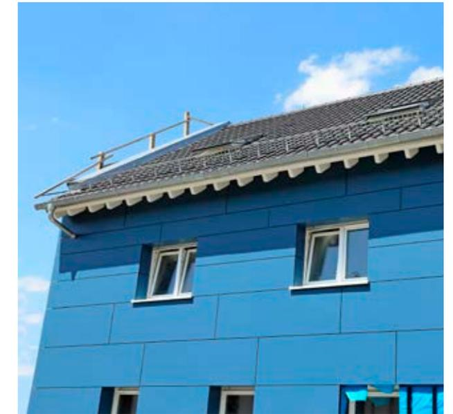
Ein Gebäude mit Kunststoff-Verkleidung und zugeklebtem Sockel kann nicht „atmen“, die Feuchtigkeit im Haus nicht nach außen ableiten.
