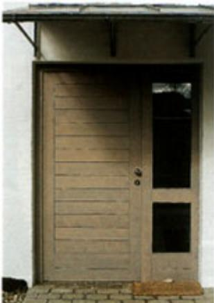
Geschützter Eingangsbereich mit leichtem Wetterschirm als filigrane Stahl-Konstruktion.
